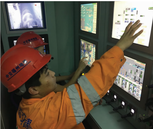
福州地铁2号线金祥区间下穿多个风险源,图为盾构司机认真操作机器。(崔士征/摄)
