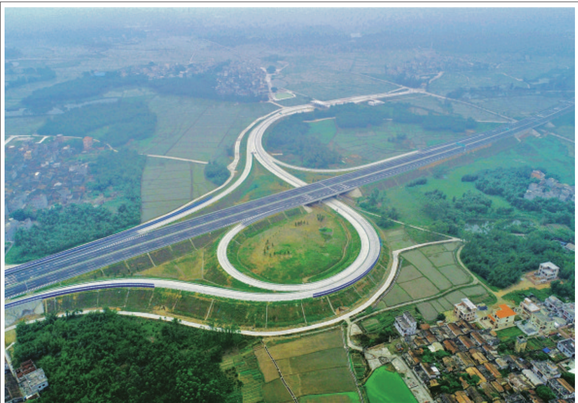
近日,二航局参建的广东省佛山市高明区至江门市恩平市高速公路(简称“高恩高速”)全线通车。自此,粤西迎来通往粤港澳大湾区城市群的又一交通动脉。李超美 黄克 摄影报道
