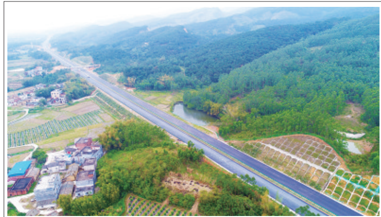
近日,一航局承建的广西贵隆高速公路路面项目完成沥青混凝土上面层试验段施工,各项指标满足施工要求,接下来将迎来该层面大面积施工。沥青混凝土上面层为整个路面结构最上层,其各项指标与行车安全息息相关。陈曦 摄影报道
