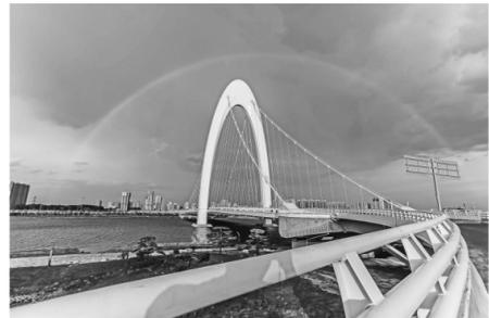
日前,中交一公局集团承建的山西省首座独塔悬索桥、太原市最高桥梁——通达桥正式通车(如图)。通达桥全长1.54公里,主桥为独塔四跨自锚式悬索桥,塔高123.5米。该桥建成后,将极大地改善太原南部地区的出行条件,构建更加便捷的公路交通网络,促进区域经济发展。
