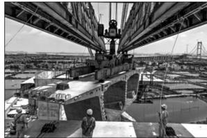
南沙大桥采用整体式钢箱梁,具有良好的抗风稳定性。
